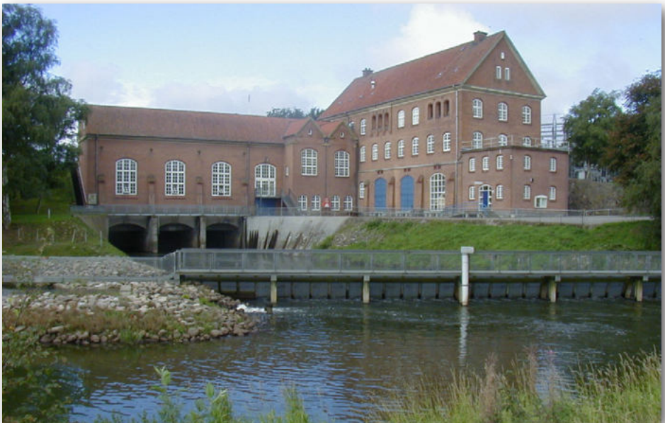
Tangeværket, der i fiskerikredse er ved at være Jyllands mest berømte bygningsværk.
