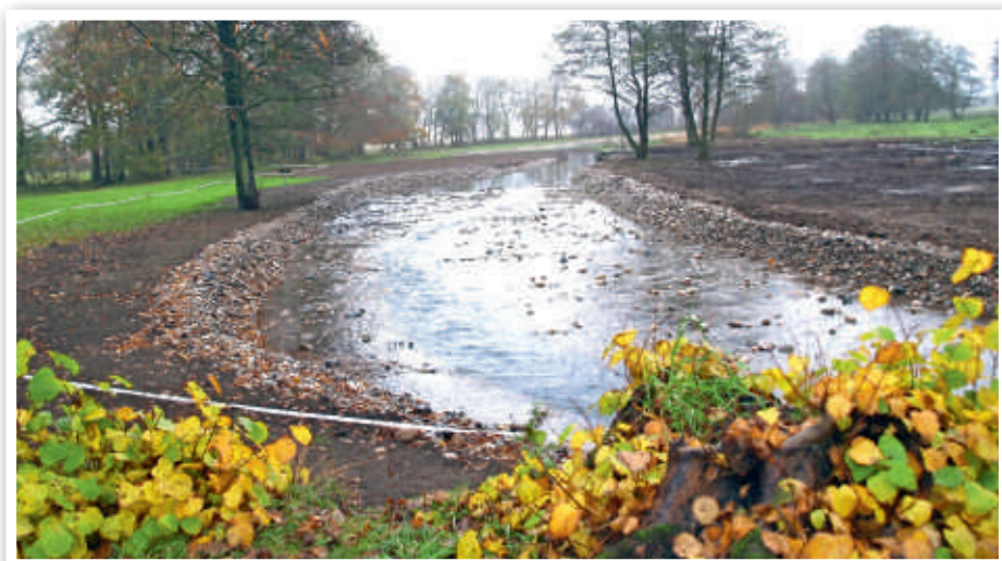
Renovering af vandløb er normalt en kommunal opgave som her i Helleved Å i Slagelse Kommune
