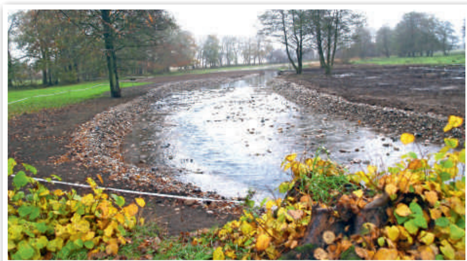
Renovering af vandløb er normalt en kommunal opgave som her i Hellevad Å i Slagelse Kommune
