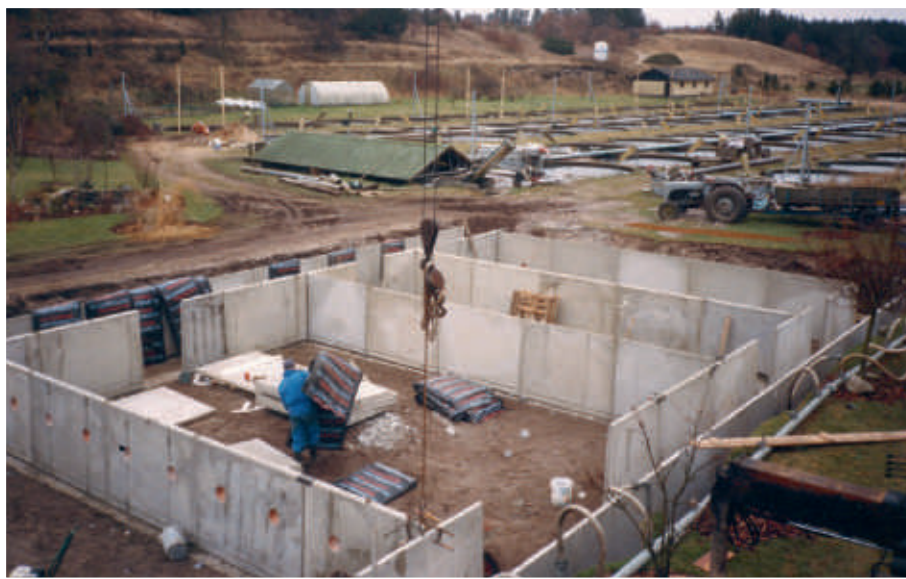
Det var dette element-bassin hos Søren Simonsen i Ejstrupholm, der i 1988 satte det hele i gang for Give Elementfabrik med hensyn til at producere dambrugsbassiner
