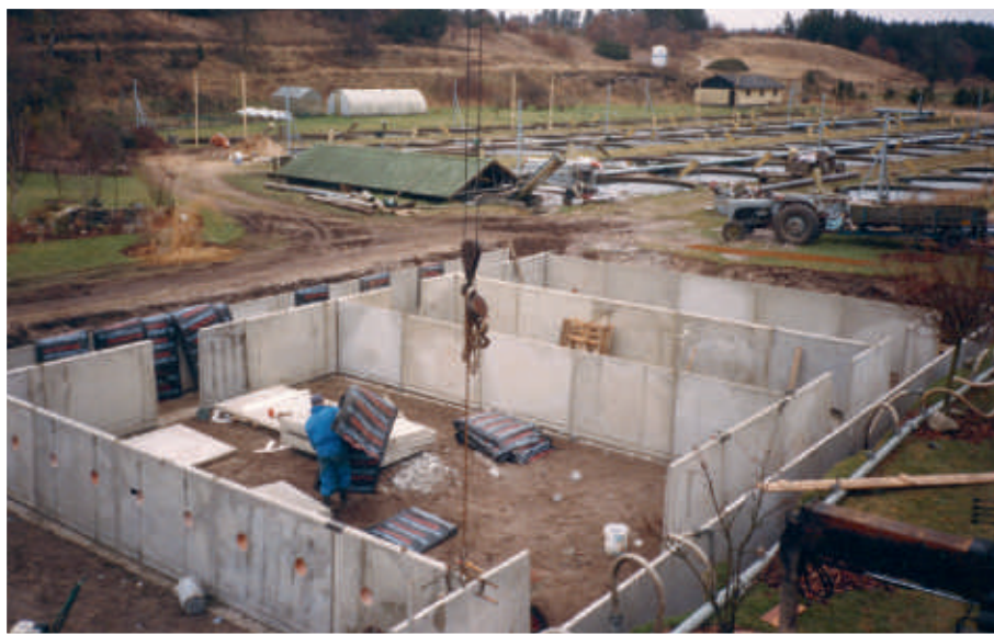
Det var dette element-bassin hos Søren Simonsen i Ejstrupholm, der i 1988 satte det hele i gang for Give Elementfabrik med hensyn til at producere dambrugsbassiner
