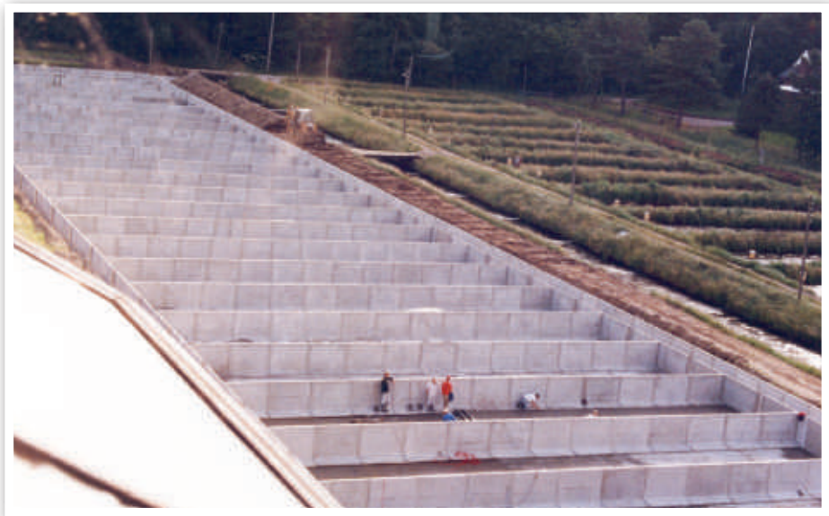
De "små" mennesker her i det store anlæg i Rindsholm, som udelukkende er opbygget af L-150-elementer, giver et godt indtryk af hvor stort dette dambrugsbyggeri i virkeligheden er
