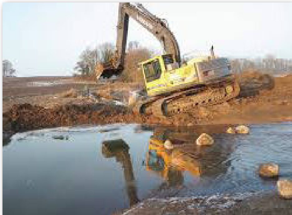
Det store gravearbejde er i fuld gang.
