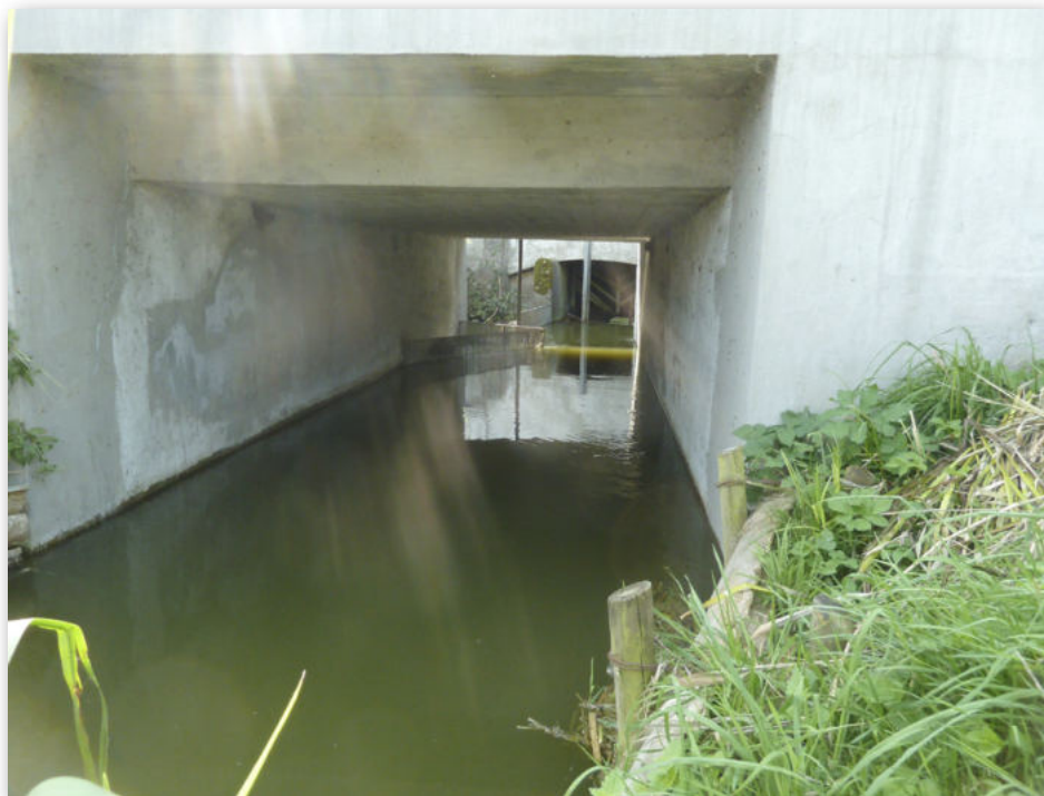
Her er det oprindelig indløb til ålekisten under ejendommen i Klejtrup.
