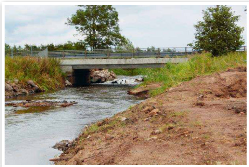
Stemmeværket ved Fole Dambrug er væk og snæbelen har fri adgang til nye gydeområder
