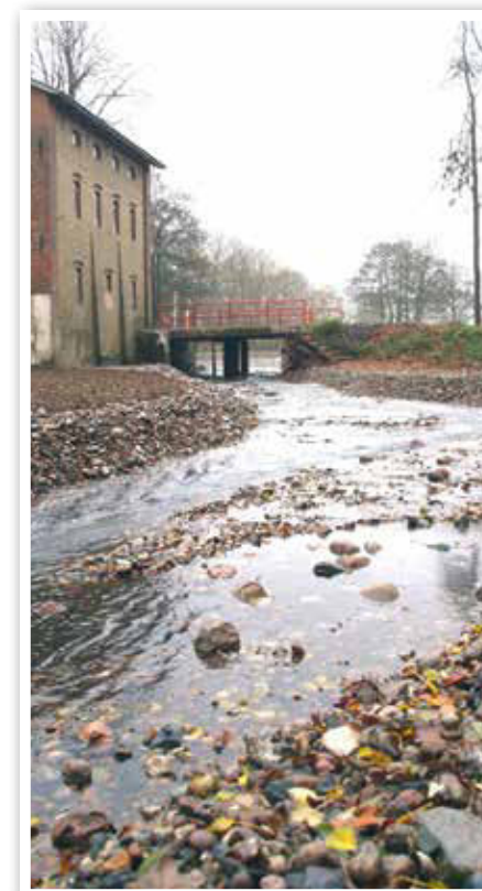
Her et godt eksempel på, hvordan man for en del år siden fik fjernet spærreværket ved Hellevad Mølle Dambrug.
