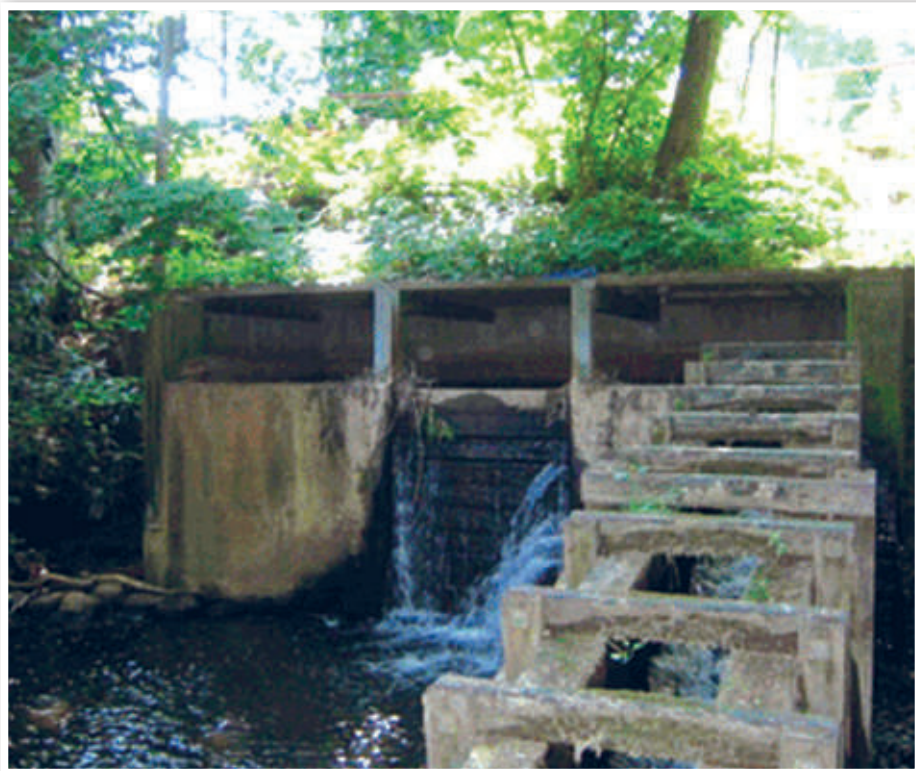
Opstemning og fisketrappen ved Halkevad Mølle – nu er der fri passage.
