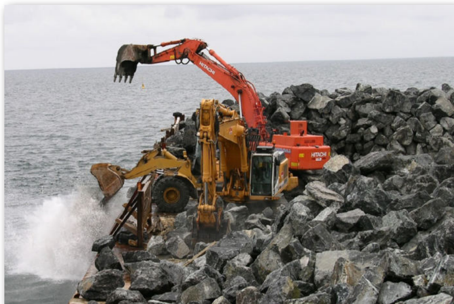
Det er store maskiner, der tager fat, når et stenrev skal anlægges.
