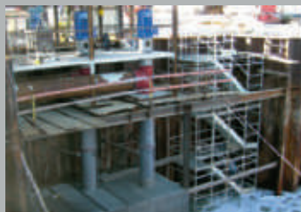
Dokpumper til skibsværft, tørdok installation.
