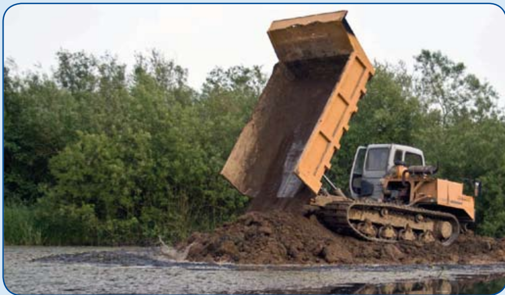
De store maskiner nåede at flytte 35.000 kubikmeter jord, mens arbejdet stod på
