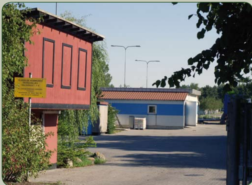
Det kommunale rensningsanlæg i Slagelse som "løb over" i regnvejret
