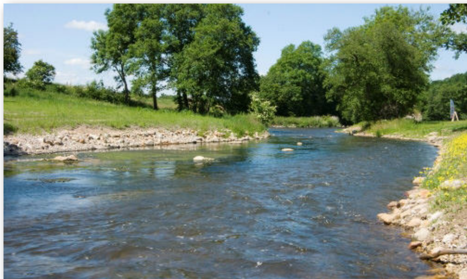
Renoveret vandløb i god økologisk tilstand.
