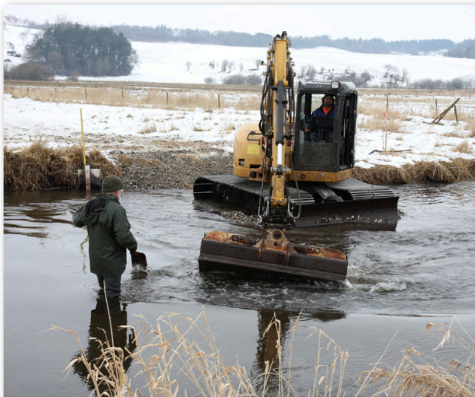
Udlægning foregik med maskinhjælp – hvilket naturligvis var en vigtig hjælp.
