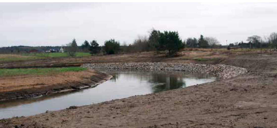
Det nye vandløb, der leder vandet uden om Gelsbro Dambrug.
