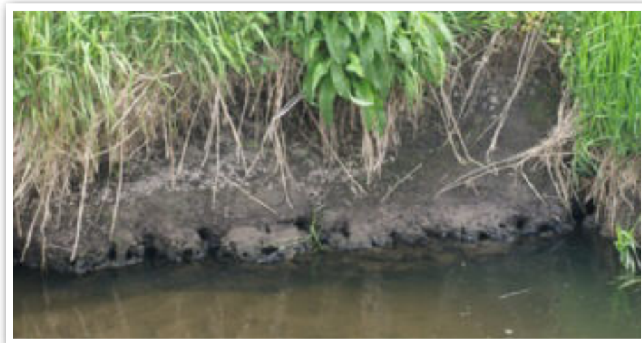
Brinken i Alling Å er stærkt ødelagt af signalkrebsens huller med nedstyrtninger som resultat.
