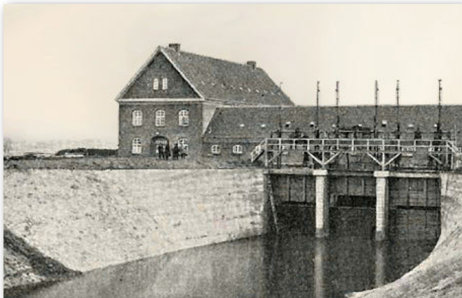
Da Tangeværket blev bygget i 1921, uddøde den oprindelige laksebestand i Gudenåen.
