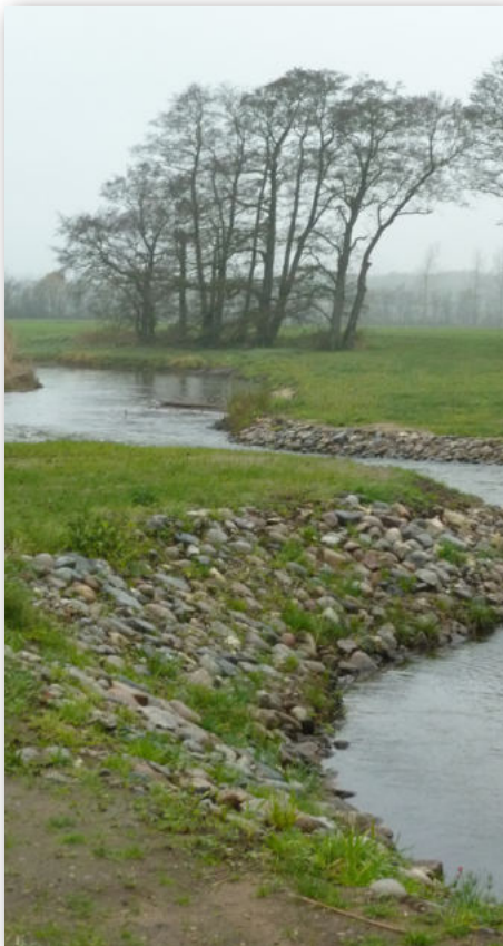
Ved etablering af et omløbsstryg i Gram Slotssø blev der i 2014 skabt adgang til 100 km vandløb opstrøms omløbsstryget ved Gram Slot.
