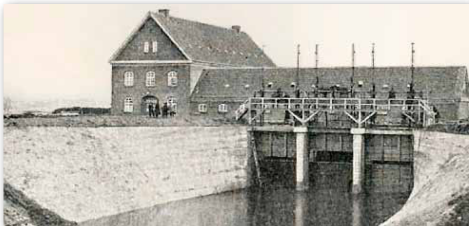
Tangeværket, da det blev taget i brug i 1921, som en vigtig del af Danmarks el-forsyning.
