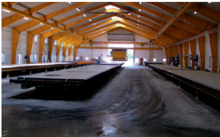
Den nuværende produktionshal i Give har god plads til udvikling af nye elementsystemer.
