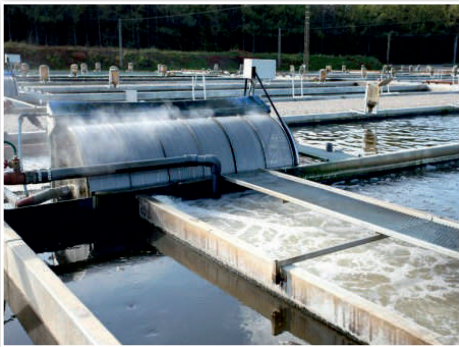
Mekanisk rensning før biofiltret på et moderne dambrug.
