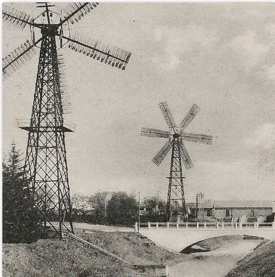
I 30'erne var vindkraften en væsentlig del af den energi, der sørgede for at pumpe vandet ud fra det store inddæmmede landområde.
