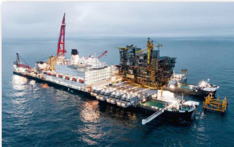
På havbunden i Nordsøen står en række store stålkonstruktioner. Det er olieboreplatforme, og der er 67 af dem i dansk sektor. Denne her fra Thyra-feltet er under nedrivning.
