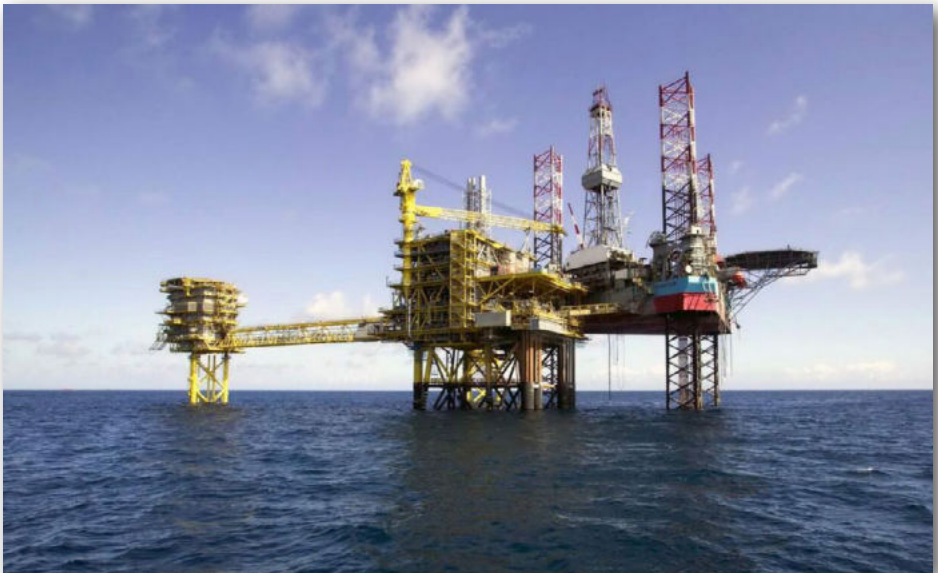
Dansk boreplatform med tårn under nedrivning i Nordsøen.
