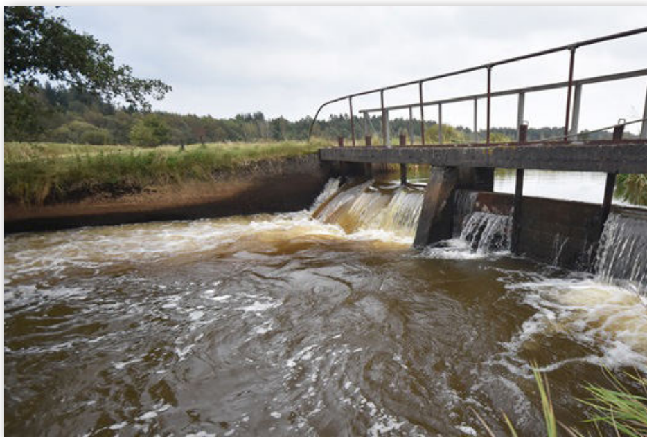
Netop en spærring som denne gør det vanskeligt for alle vandrende fiskearter at passere. (Foto: Finn Sivebæk)
