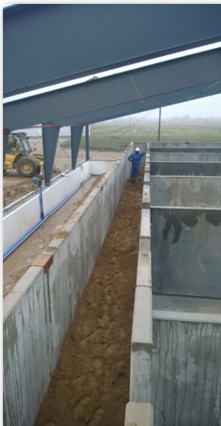
Her er det standardelementer, der er anvendt i det omfattende byggeri.
