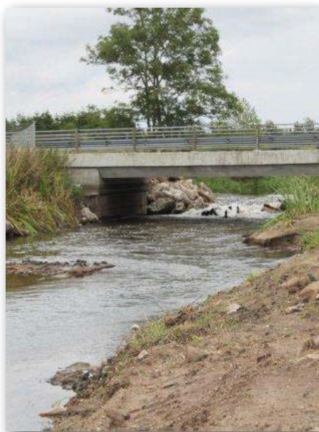
Ved Fole Dambrug er flere spærringer fjernet, så der igen er frit løb i åen.
